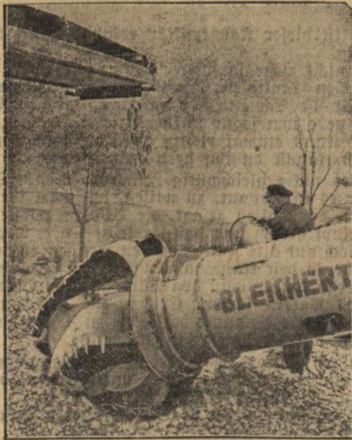
findergest. Links sieht man eine neuartige Wetterlampe, die sich selbstständig beim Beden der Uhr einschaltet. Rechts: ein Augenschäufel, der Sand und Steinschotter aufnimmt, um sie einem laufenden Band zuzuleiten. (Scherl-Bilderdienst — R.)
