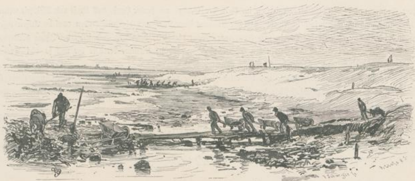
Deichbau nach der Hochflut.
