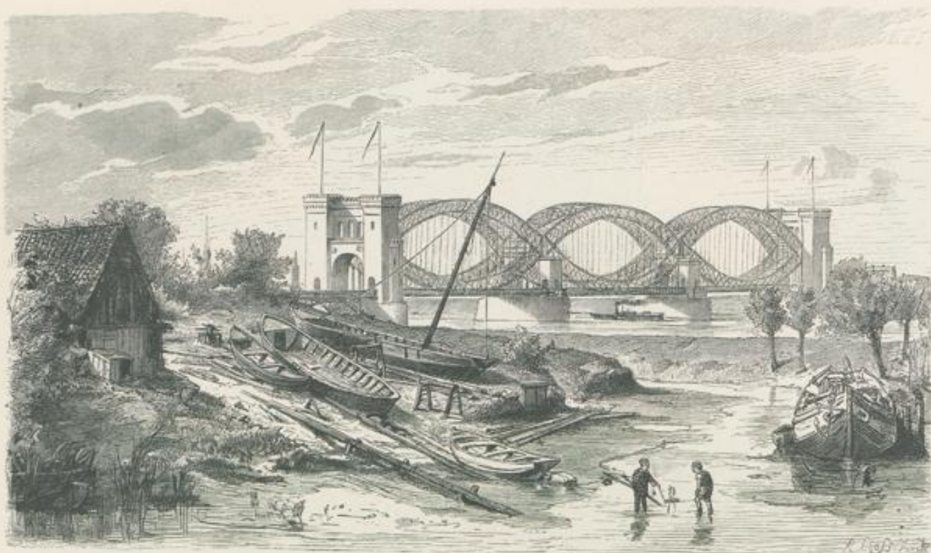
Pariser Eisenbahnbrücke in Hamburg.
