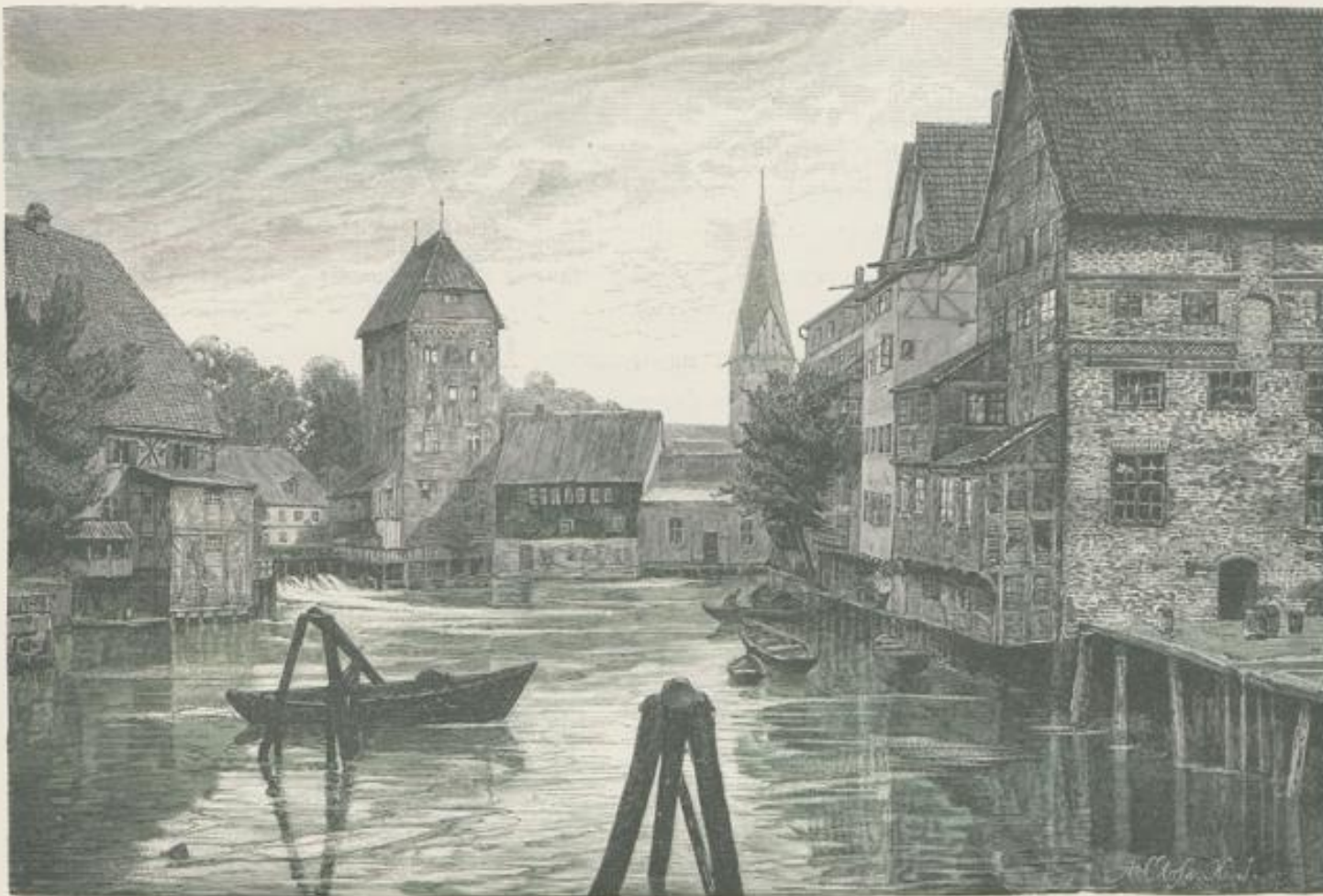
Die Abtsmühle in Lüneburg.
