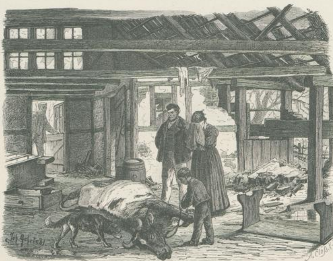
Nach der Sturmflut: Zerstörtes Haus.
