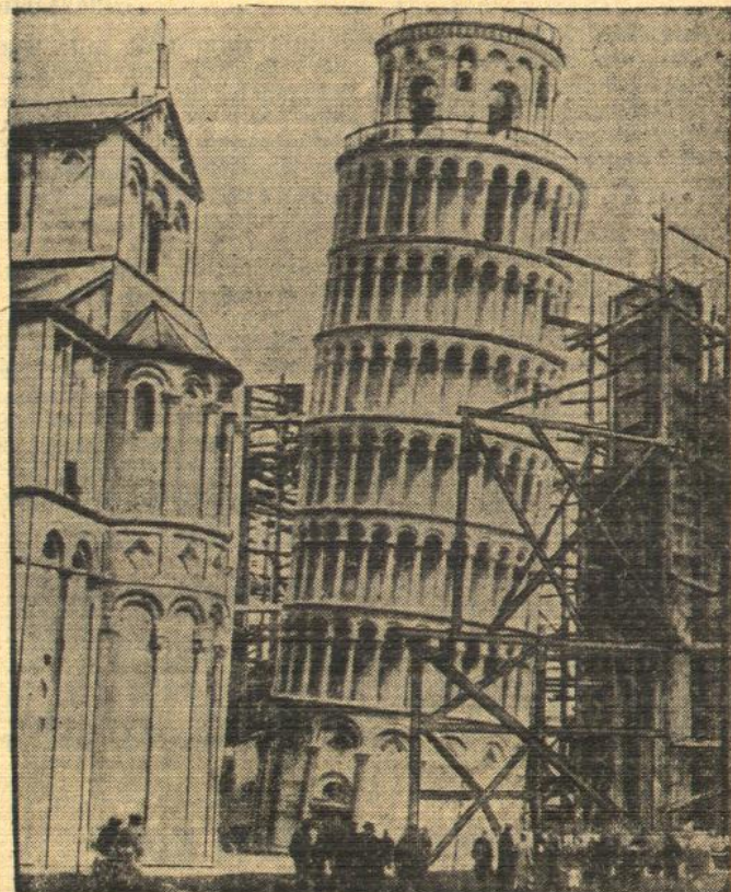
Mussolini läßt den schiefen Turm von Pisa geraderichten Der weltberühmte Marmorturm von Pisa mit dem komplizierten Gerüst, das für die Geraderichtung aufgebaut wurde.
