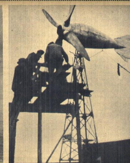
Eine neuartige Windkraftmaschine, die ein Hamburger Schlossermeister erfunden und auf dem Dach seines Hauses aufgebaut hat. Mit der Maschine stellt er den für seine Werkstätte erforderlichen Strom selbst her. (Atlantik.)
