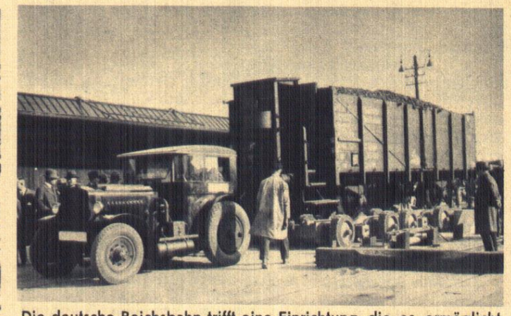
Die deutsche Reichsbahn trifft eine Einrichtung, die es ermöglicht, ganze, vollbeladene Eisenbahnwagen dem Empfänger zuzustellen. Die neue Einrichtung dürfte sich sicher für Güter, denen mehrmaliges Umladen schadet, rasch einführen.
