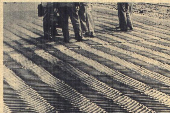
Eisstraßen für Deutschland? Bei Düsseldorf wurde zum ersten Male eine Straße mit einer Oberfläche aus Stahl ausgerüstet. Im Vordergrund die Eisstraße ohne Leerfüllung, in der Ecke links oben ein Teil der fertigen Eisstraße.
