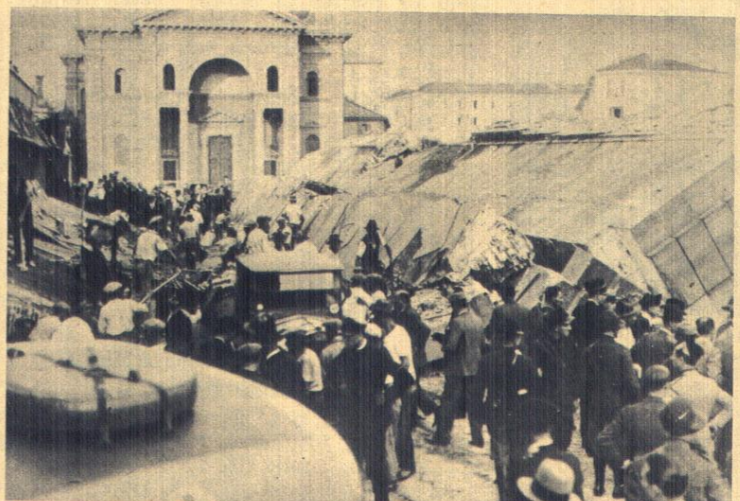
Bei den seit Monaten im Gange befindlichen Abbrucharbeiten des alten Mainländer Hauptbahnhofes stürzte eine gleichfalls in Abbruch befindliche Eisenbahnüberführung auf die darunter befindliche Verkehrsstraße und begrub eine größere Anzahl Passanten unter sich.
