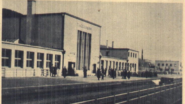
Die Stadt Tuttlingen an der Donau, ein wichtiger Eisenbahnknotenpunkt an den Strecken Berlin-Stuttgart-Schaffhausen-Zürich und München-Ulm-Freiburg i. Br. hat einen neuen modernen Bahnhof erhalten. Für den Bau des Bahnhofs mußte das Donauebett um einige Kilometer verlegt werden.
