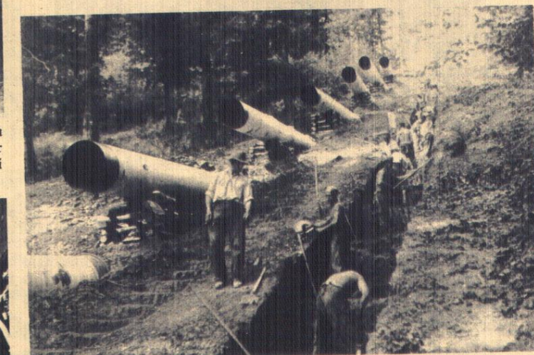
Keine deutsche Aufrüstung, sondern friedliche Rohrverlegungsarbeiten an einer schwierigen Steilstrecke. Die nahtlosen Stahlmuffenrohre von 80 Zentimeter Innendurchmesser wurden von den Röhrenwerken der Vereinigten Stahlwerke A.G. in Düsseldorf für die Landeswasserversorgung Württembergs geliefert.
