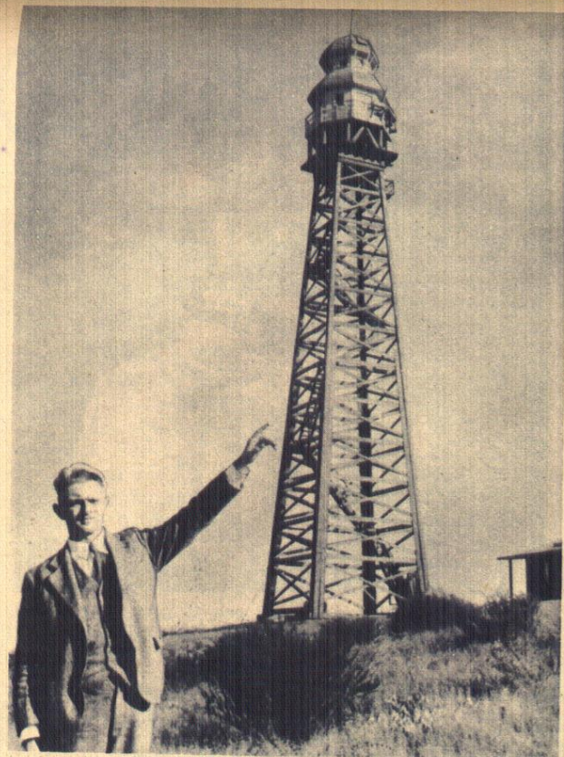
Der amerikanische Erfinder William Haight hat in Whittier (Kalifornien) einen Sendeturm errichtet, der negativ geladene elektrische Ströme ausstrahlt und dadurch die Obstgärten der Ortschaft vor Frostgefahr schützen soll. Die elektrischen Strahlen sollen auch den Bodennebel derart auflösen, daß eine klare Sicht ermöglicht ist. Dies schafft der Erfindung große Möglichkeiten, z. B. zur Markhaltung der Einfahrt von Schiffs- und Flughäfen usw.
