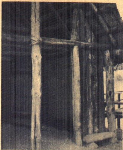
Der Vorplatz des steinzeitlichen Gemeindehauses. Man beachte die ganz primitive Bauart! Die Balken werden noch durch Bänder miteinander verbunden.
