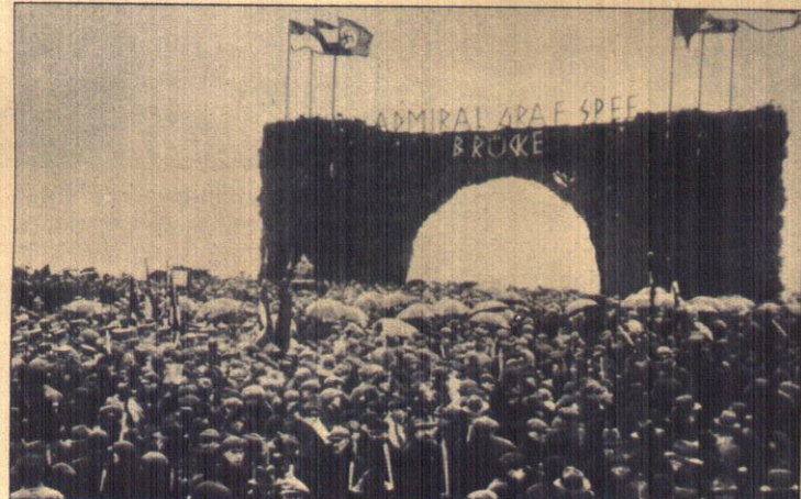
Unter gewaltiger Anteilnahme wurde der erste Spatenstich für den Bau der neuen Rheinbrücke Duisburg-Rheinhausen, die den Namen ‚Admiral-Graf-Spee-Brücke‘ tragen wird, getan.
