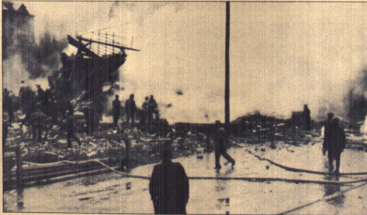
In der Königstraße in Plettenberg im Sauerland ereignete sich eine Gasexplosion, durch die ein Wohnhaus zusammenstürzte; dabei kamen vier Personen ums Leben. Durch die Gewalt des Luftdruckes wurden auch in den benachbarten Häusern sämtliche Fensterscheiben zerstört, und die Flammen, die die Trümmer des eingestürzten Hauses umhüllten, drohten auf die anliegenden Gebäude überzugreifen. Als Ursache des Unglücks vermutet man Undichtigwerden einer in der Nähe des betroffenen Hauses vorbeifahrenden Ferngasleitung.
