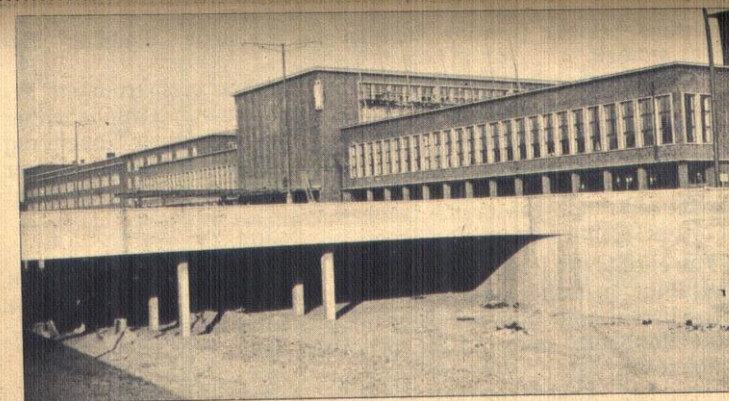
Bei dem neuen Hauptbahnhof von Duisburg-Hamborn ist eine neuartige Lösung des Verkehrs-Problems vor großen Bahnhöfen praktisch durchgeführt worden. Unter dem Bahnhofsborsplatz, der nur dem Fußgängerverkehr dient, und der gesamte Fahrzeug-Verkehr durch eine Tunnel-Estrade an den Bahnhof herangeführt.
