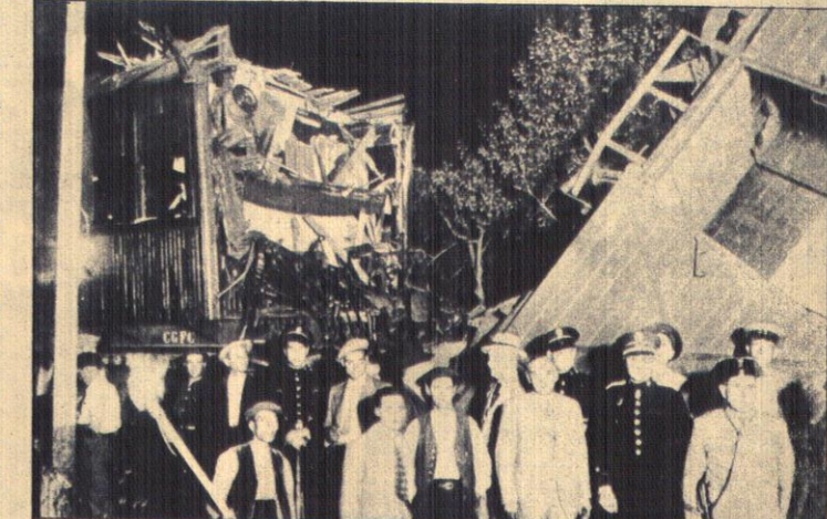
In Barcelona ereignete sich ein schweres Eisenbahnunglück, das 20 Tote und 25 Schwerverletzte forderte. Die Katastrophe ist darauf zurückzuführen, daß der Lokomotivführer eines zur Abfahrt bereitstehenden Personenzuges vor der fahrplanmäßigen Zeit abfuhr, weil er den Pfiff eines Fahrgastes für das Abfahrtsignal hielt, und dadurch kurz nach der Ausfahrt mit einem anderen Personenzug zusammenstieß.
