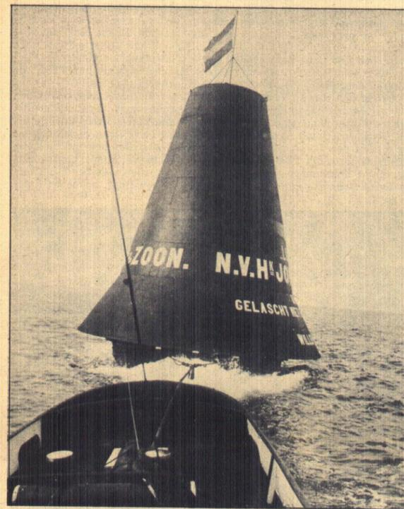
Der Turm zur Hebung des Goldes. Das Gold des 1799 gesunkenen Schiffes „Lutino“ läßt Holland auch jetzt noch dem letzten mühsamsten Hebungversuch noch nicht ruhen. Es wurde ein Regel von 19 Meter Höhe und 12 Meter Durchmesser aus Stahl konstruiert, der 17 000 Kilogramm wiegt. Er wird auf der Bergungsstelle versenkt, um den Sand über dem versunkenen Schiff auszupumpen. Bild zeigt den Abtransport des neuen Regels zur Bergung des Goldes.
