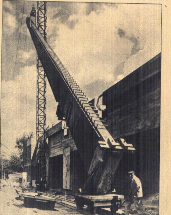
Von den Vorbereitungen für den Reichsparteitag Nürnberg 1934 — Besonders Auffsehen erregte die Aufstellung von 4 gewaltigen stählernen Fahnenmasten in geschweißter Konstruktion, deren Herstellung einschließlich der mechanischen und hydraulisch-pneumatischen Sicherung gegen die Kraft des Windes dem Werk Nürnberg der Maschinenfabrik Augsburg-Nürnberg A.G. übertragen worden war.
