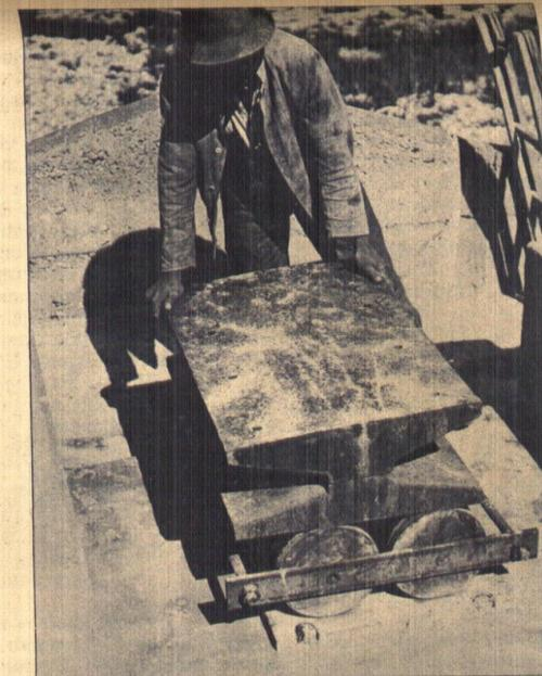
Ein Eisenrollenlager der größten Eisenbetonbrücke (Innbrücke), das, aus einem neuen Kruppstahl hergestellt, einen ständigen Druck von 400 Tonnen auszuhalten vermag. Die obere der auf den Rollen liegenden Stahlplatten ist als Kippplatte ausgebildet, so daß der Brücke jede Art der Bewegung ermöglicht wird, wie sie Temperaturschwankungen und Schwingungen hervorrufen können. — Dieses Rollenlager ist die letzte und größte Errungenschaft deutscher Brückenbaukunst.
