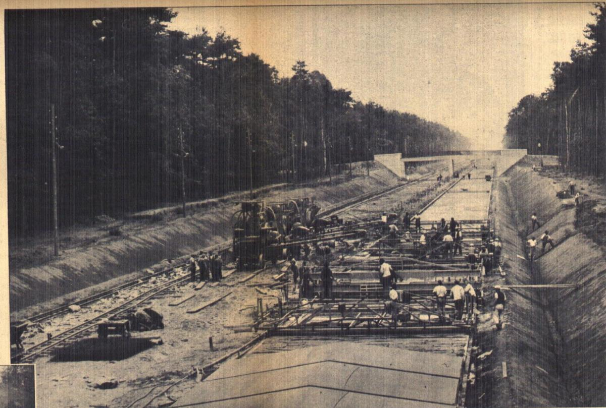
Betonierungsanlage mit Schutzzelt (im Vordergrund) für fertige Straßendecken (Autobahnstraße Frankfurt a. M.—Heidelberg).
