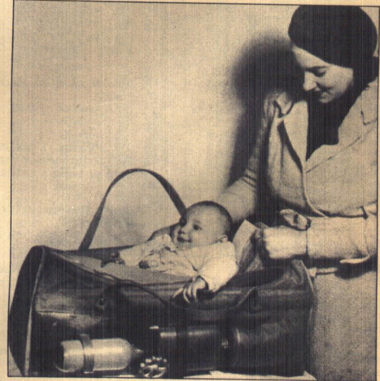
Die gassichere Tasche für den Säugling mit der von außen zu regelnden Sauerstoffzufuhr, wurde von einem Pariser Ingenieur erfunden.
