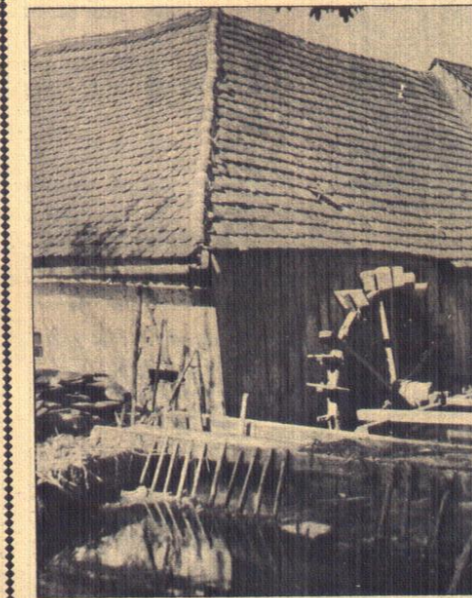
„In einem kühlen Grunde . . .“ (Klostermühle in Thierhaupten.)
