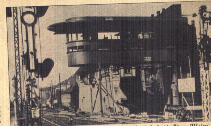
Das modernste Stellwerk der Welt. Die Reichsbahndirektion Mainz hat ein Stellwerk errichten lassen, das nach den modernsten Grundsätzen ausgeführt wird. Es schwebt trotz seiner Größe frei wie eine Zeppelingskugel in der Luft, nur an der Schmalseite befinden sich zwei Eisenträger, der übrige Bau trägt sich durch elektrische Verschweißung des Außenmantels selbst. Das neue Stellwerk wird in Zukunft den gesamten Zugverkehr von rund 250 Zügen am Tage regeln. (Scherl)
