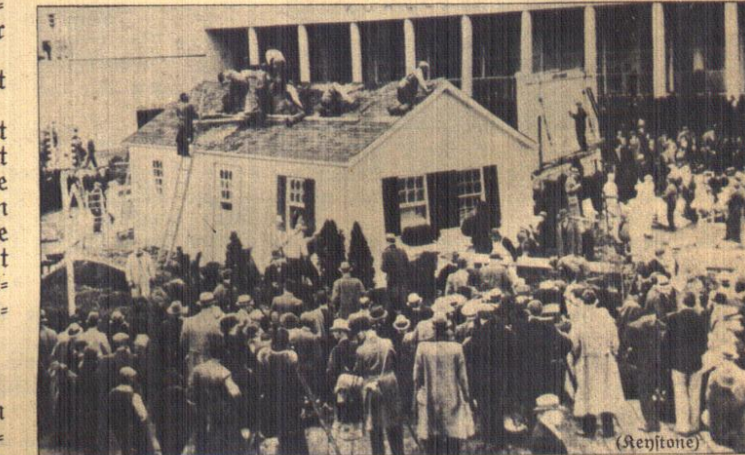
Ein Haus in sieben Stunden erbaut. Auf der Chicagoer Weltausstellung lockt der Stand einer Baufirma für Landhäuser immer Scharen von Besuchern an. In dem Rekordtempo von sieben Stunden wird hier ein niedliches Landhaus mit grünen Fensterläden und Blumenkästen vollkommen wohnfertig aufgebaut.
