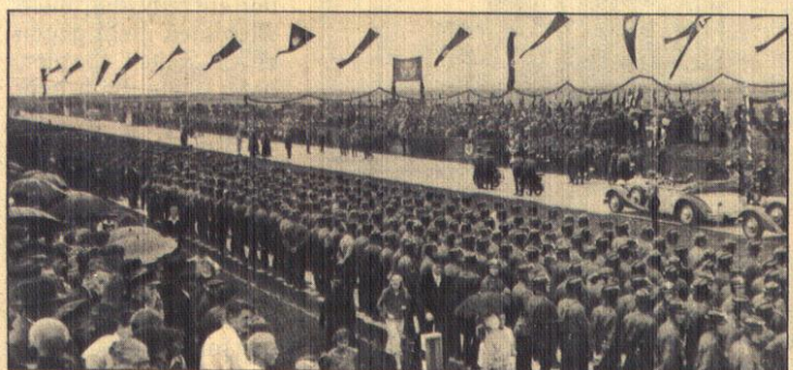
Reichsautobahn Bremen—Harburg dem Verkehr übergeben. Mit einer schlichten Feier in Anwesenheit des Reichsorganisationsleiters Dr. Ley und des Gauleiters Telschow, wurde am 26. Juli die Reichsautobahn Bremen—Harburg dem Verkehr übergeben.
