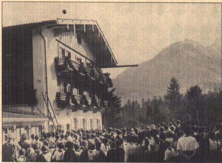
Eine neue Jugendherberge inmitten der herrlichen Berchtesgadener Berge wurde am 18. Oktober durch den Reichsjugendführer feierlich eingeweiht. — Baldur von Schirach begrüßt vom Balkon der neu eröffneten Wolf-Hütler-Jugendherberge die angetretenen Formationen der S. J. und des B. D. M. Suble
