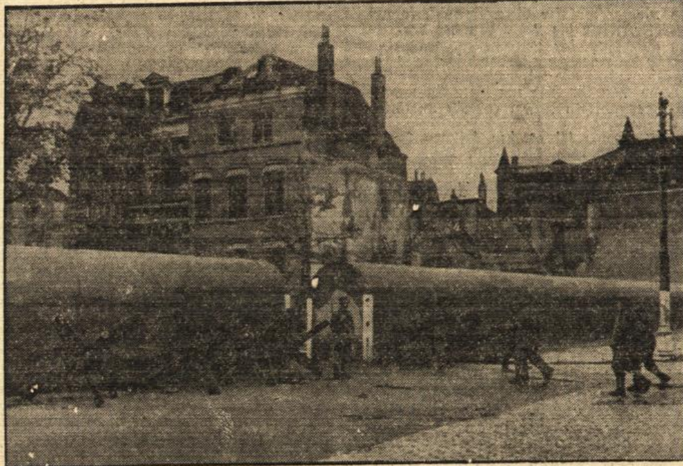
Eine der zahlreichen Panzerspermauern die zur Sicherung einer Hafenstadt an der Kanalküste errichtet wurden. (PK-Aufnahme: Kriegsbilderer Chevalier, AUL, Z.)
