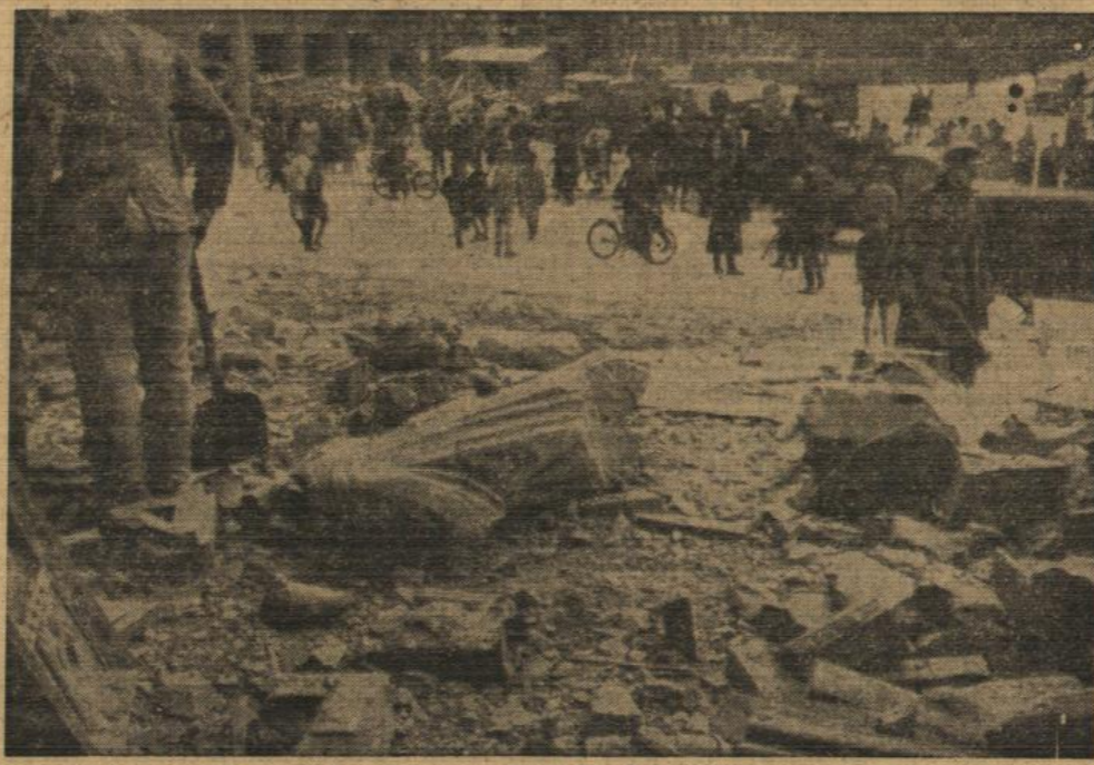
Die Bomben der Terrorflieger haben bei dem Angriff auf Köln am 3. November erneut den Dom schwer getroffen. U. a. wurden, wie unser Bild zeigt, unersetzliche Skulpturen zertrümmert. PK-Kriegsberichterstatter Viemetti.
