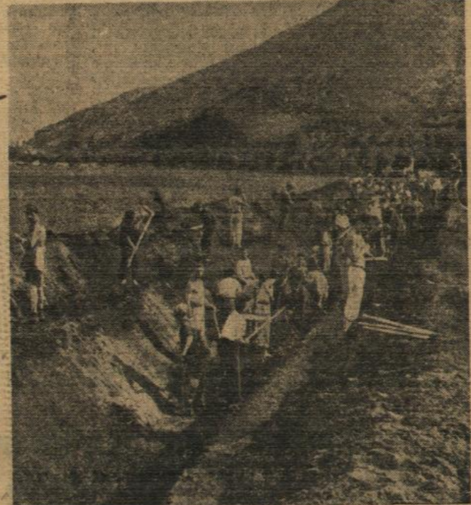
An der süditalienischen Front Italienische Arbeiter, die von deutschen Soldaten beaufsichtigt werden, beim Bau eines Panzergrabens. - PK.-Kriegsb. Sprotte (PBZ - Sch)
