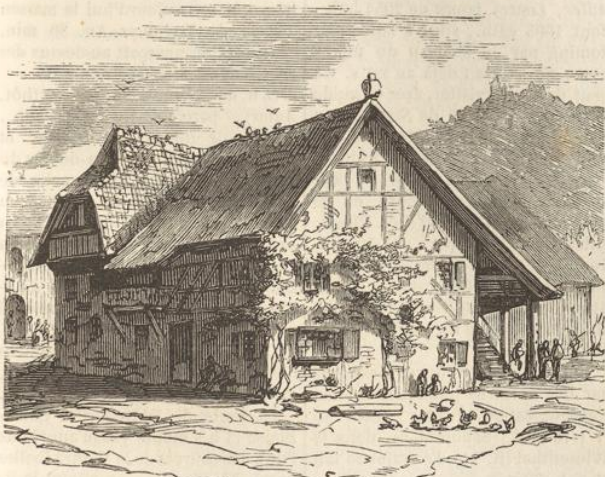
Maison de Hebel, à Hausen.
