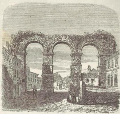
Aqueduc de Jouy.
