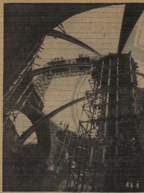
Blick in das Innere des Kuppelraums nach Beginn der Montagearbeiten im Juni 1949. Gerade wird ein Segment hochgezogen. Fotos: Walter Schmidt
