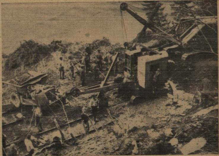
An der gleichen Stelle, an der im April 1951 eine Lawine den Gotthardzug verschüttete, ging in der Nacht zum 28. Mai ein Erdrutsch nieder, der die Gleise der Gotthardbahn auf einer Breite von etwa 50 Meter überdeckte. Unser Bild zeigt die Aufräumarbeiten an der Unglücksstelle bei Airolo. (dpa)
