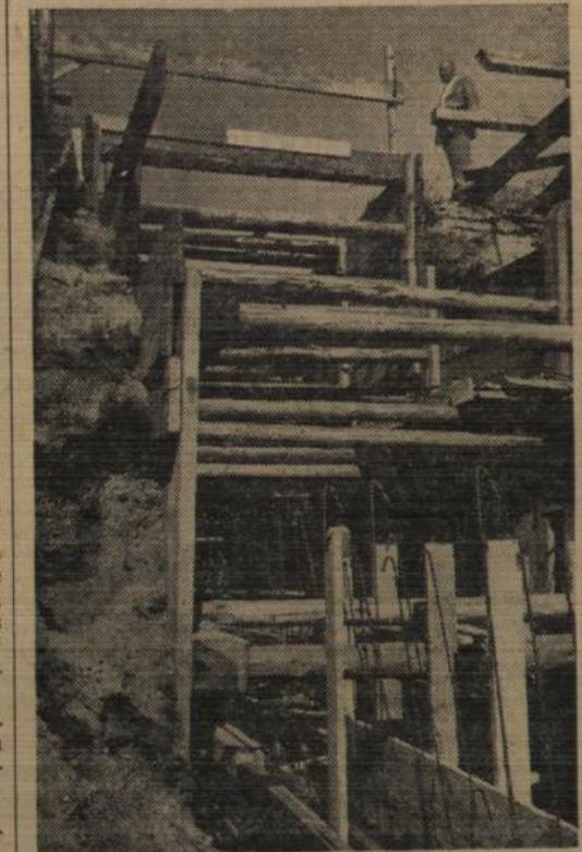
Der Durchbruch durch den Damm der Hardtbahn bereitete nicht unerhebliche Schwierigkeiten. Sieben Meter unterhalb der Geleise werden die Rohre verlegt.
