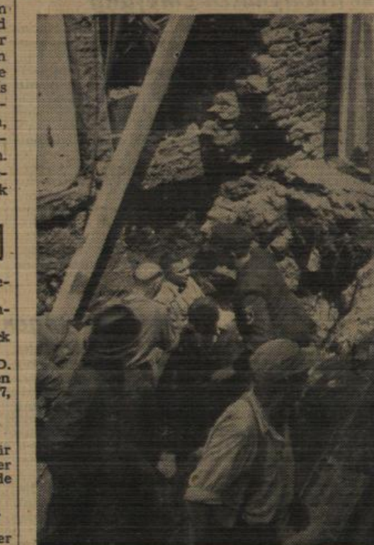
Einer der verschüttet gewesenen Arbeiter wurde aus den Trümmern geborgen. Foto: Schmeiser
