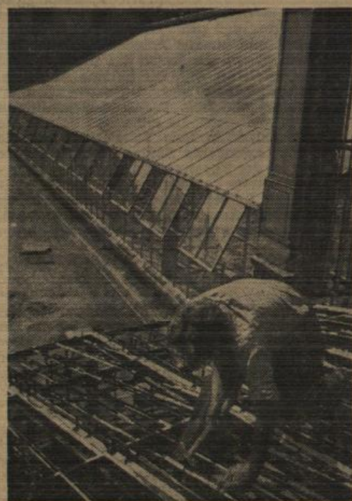
Rund 500 qm Glas waren nötig, um den linken Flügel des Gewächshauses zu verglasen. Im Vordergrund des Bildes ist ein Arbeiter gerade dabei, das zum Verschnitten bestimmte Gerüst des Viktoria-Regia-Hauses abzumontieren. Foto: Schlesiger
