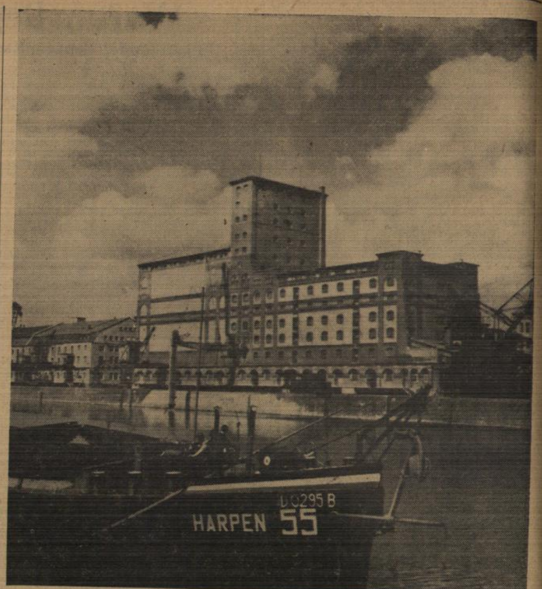
Das im Krieg teilzerstörte, in den vergangenen Jahren vergrößert wieder aufgebaute Getreidelagerhaus am Mittelbecken. Foto: Erich Bauer
