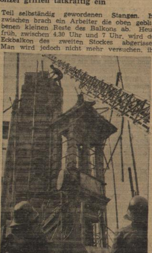
Nachdem der Eckbalkon zum Teil auf die Straße „abgefahren“ war, brach, wie unser Bild zeigt, ein Arbeiter die oben gebliebenen kleinen Reste des dritten Stockwerks ab...
