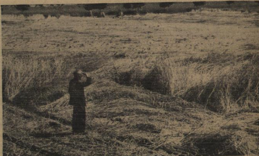
Manöverschäden in der britischen Zone
