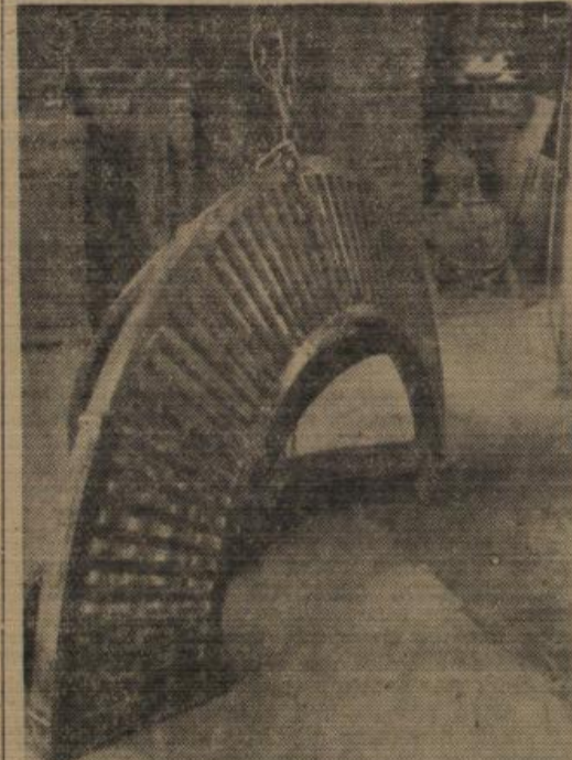
60 Zentner wiegt dieses ursprünglich zweimal gebrochene Turbinenrad, das nun nach erfolgreicher Schweißung auf seinen Abtransport ins Murgtal wartet.
