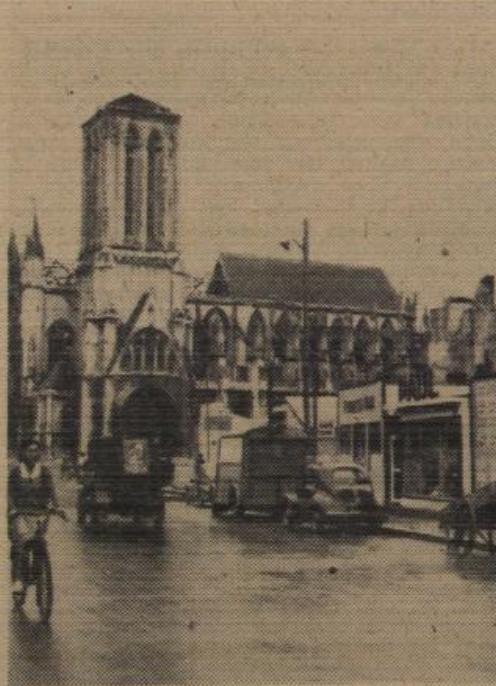
Das normannische Caen versank während der Invasionskämpfe in Schutt und Asche. Auch hier begann das neue Leben in einstöckigen Holzbauten. Bild: Fennel
