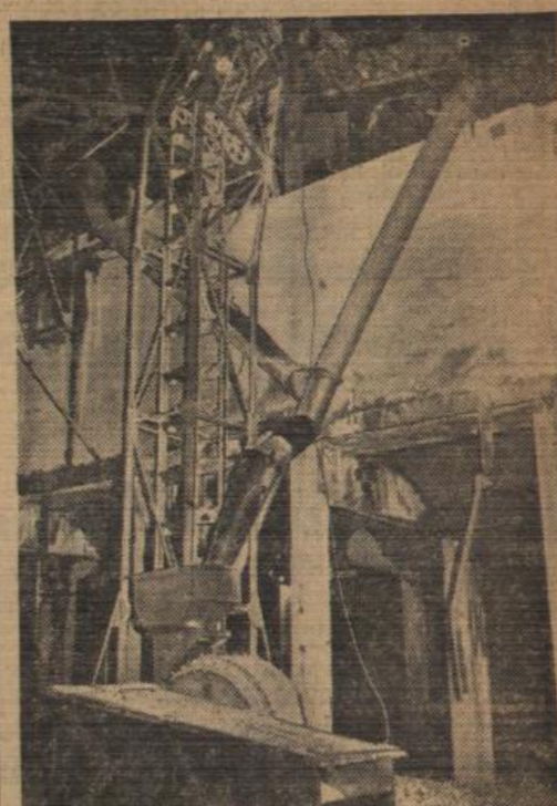
Ein wesentlicher Teil des weithin vernehmbaren nächtlichen Geräusches wird durch die auf diesem Bilde zu sehende Anlage verursacht: Kieseln von über 30 mm Durchmesser fällt von der Siebanlage durch Eisenblechrohre nach unten in den Mund der Brechanlage, werden dort zerkleinert und durch einen Eimerkettenbagger sofort wieder auf die Siebanlage befördert und gekörnt. Fotos: Schlesiger
