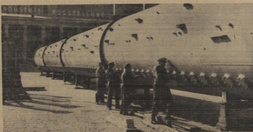
50-Meter-Kessel: Die Vorbereitungen für die Deutsche Industrie-Ausstellung in Berlin, die am 6. Oktober von Bundeskanzler Dr. Adenauer eröffnet wird und bis zum 21. Oktober andauert, laufen auf Hochtouren. Vor dem Eingang zur Ausstellung in der Massuren-Allee wurde bereits ein fast 50 Meter langer Kessel, der für eine Glühfaserbestimmte ist, und der von den Borag-Werken in Berlin-Tegel gebaut wurde, montiert. (dpa)
