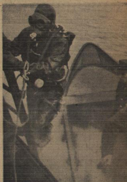
Alle verfügbaren Hilfsmittel werden eingesetzt, wenn es gilt, ein Menschenleben zu retten. Hier steigt ein mit Taucheranzug und Sauerstoffgerät ausgerüsteter Feuerwehrmann in ein Rheinhafenbecken, um einen Ertrunkenen zu bergen.
