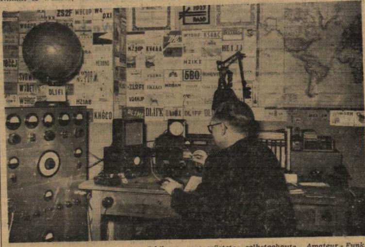
Das ist die mit allen technischen Schikanen ausgerüstete selbstgebaute Amateur-Funkstation von DL1 FI in Karlsruhe. Gemäß gesetzlicher Bestimmungen ist die Sendeleistung auf 50 Watt beschränkt. Im Vordergrund links das Sendegerät. Foto: Schlesiger.
