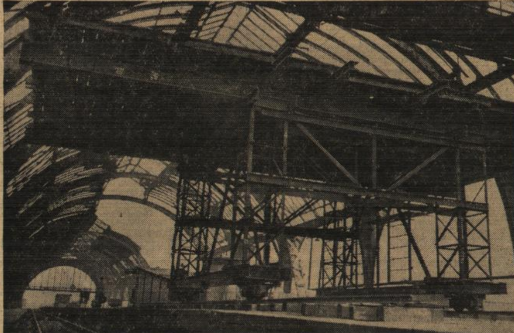
Wie wir bereits berichteten, haben Anfang Januar die Ausbesserungs- und Wiederinstandsetzungsarbeiten an der Halle des Hauptbahnhofes begonnen. Unser Bild zeigt das in diesen Tagen in Halle V aufgestellte fahrbare Baugerüst, das über die ganze Breite des Bahnsteiges hinwegreicht und durch seine Höhe den Verkehr auf den darunterliegenden Gleisen nicht behindert. Zunächst wird auf der Westseite der Halle die Stahlkonstruktion der ersten vier Bänderfelder über jedem Bahnsteig repariert bzw. erneuert. Eine zweite fahrbare Bühne, die einen Montagekran zur Beförderung schwerer Konstruktionsteile aufnehmen wird, befindet sich gegenwärtig im Bau. Auf Grund des anhaltenden Mangels an Eisen und Stahl läßt sich z. Zt. kein Termin für die Fertigstellung der jetzt in Angriff genommenen Bauabschnitte bestimmen. Fotos: Schlesiger
