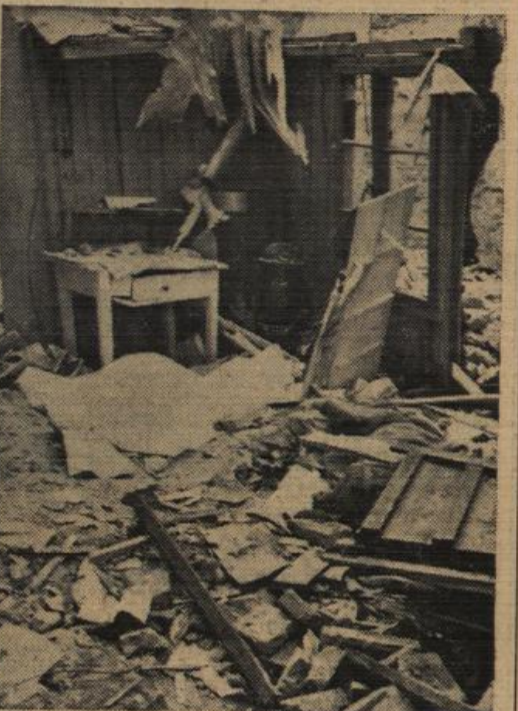
Das waren die Reste des Kiosks nach dem Unglück.
