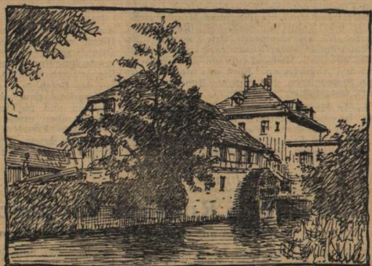
So sah die Appenmühle vor der Zerstörung aus
