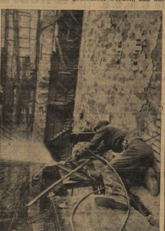
Gefährliche Arbeit: Ein Arbeiter hilft mit dem Brennschneider die Eisen- und Stahlkonstruktionen innerhalb der Ruine bergein. 210 Tonnen Schrott sind seit Herbst vergangenen Jahres abgebaut worden.
