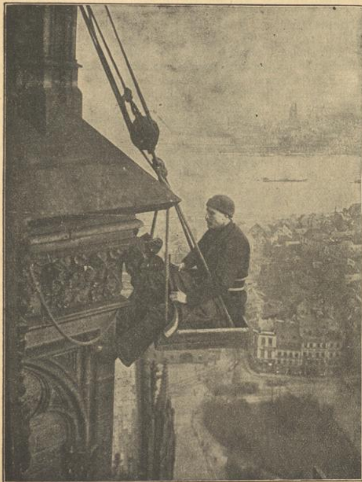
Reparaturarbeiten am Kölner Dom. Ein Arbeiter in gefahrvoller Höhe bei einer Ausbesserungsarbeit an einem der beiden Dombürme.
