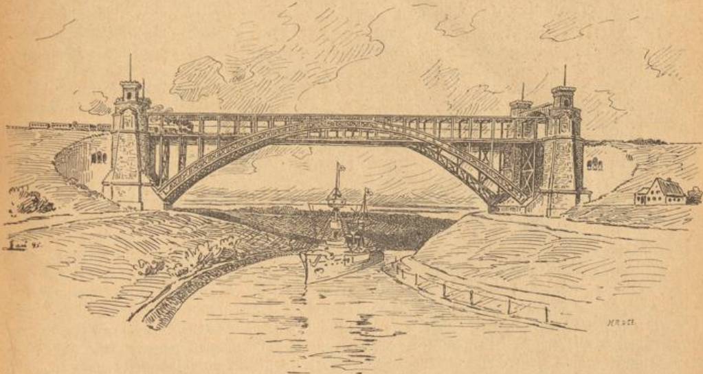
Kaiser Wilhelm-Kanal (Nordostsee-Kanal). Hochbrücke bei Levensau.
