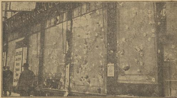
Zerschossene Schaufenster in der Lindenstraße in Berlin.
