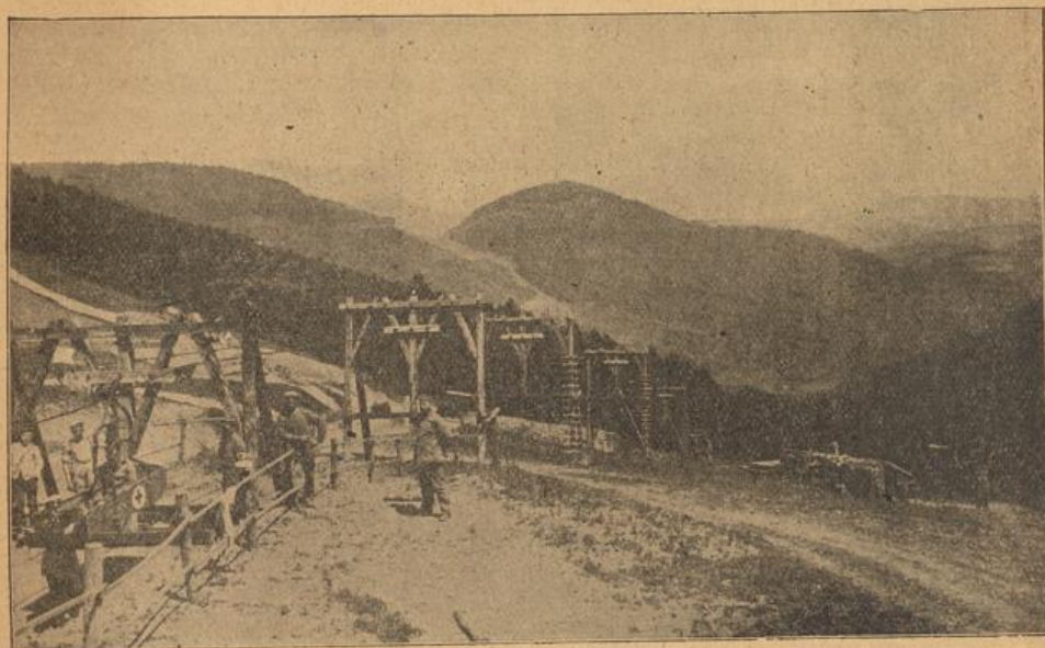
Eberhardt-Seilbahn zur Beförderung von Verwundeten in den Vogesen.
