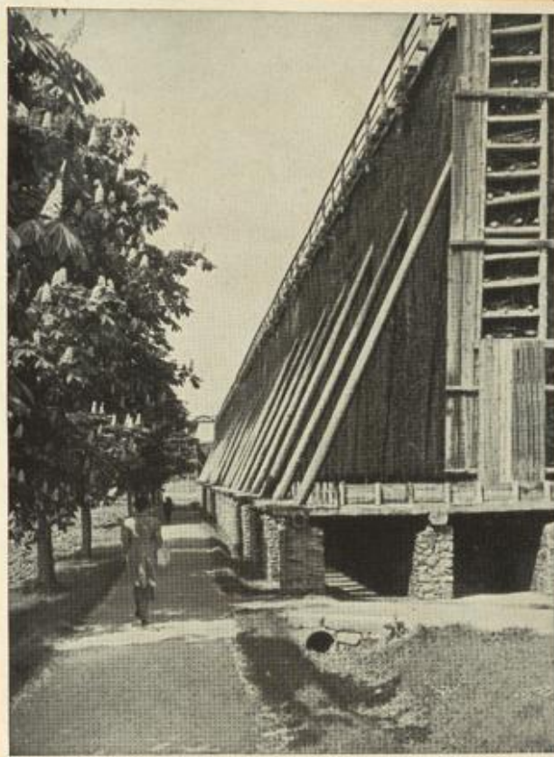
Gradieranlagen in Nauheim
