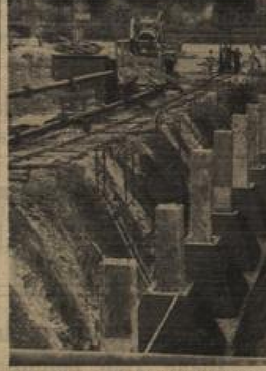
Ein seltsames Bild, nicht wahr? Es handelt sich bei diesen in die Erde eingetragenen pyramidenförmigen Gebilden um einige der 35 bis zu 150 Zentner schweren sogenannten Sohlenklötze aus Beton, die, inmitten eines Moorgrundes versenkt, das Fundament für eine ganze Fabrik abgeben. Rechts und links die Pumpenlage, die bei Tag und Nacht in Tätigkeit war, um den beim Ripperr Schilde außerordentlich hohen Grundwasserspiegel auf fünf Meter unter die Oberfläche zu drücken. Ein Bild von den außerordentlich schmerzigen, aber ebenso interessanten Gründungsarbeiten für die Wäschefabrik Stecher & Wilde, zugleich eine Illustration zu dem Artikel „Aus dem Moor erwuchs eine Wäschefabrik“ (vergleiche Seite 10).
